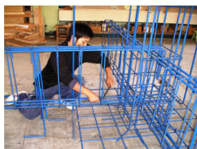
鉄筋コンクリート施工科(鉄筋コース)
